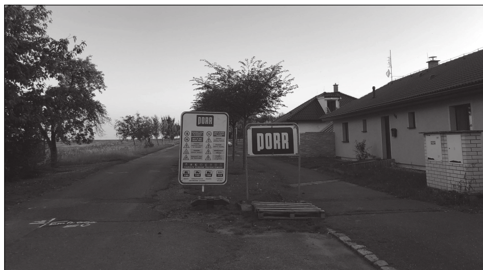
Počátek úseku stavebních prací na cestě ve Dvorech označený dodavatelem stavby.
