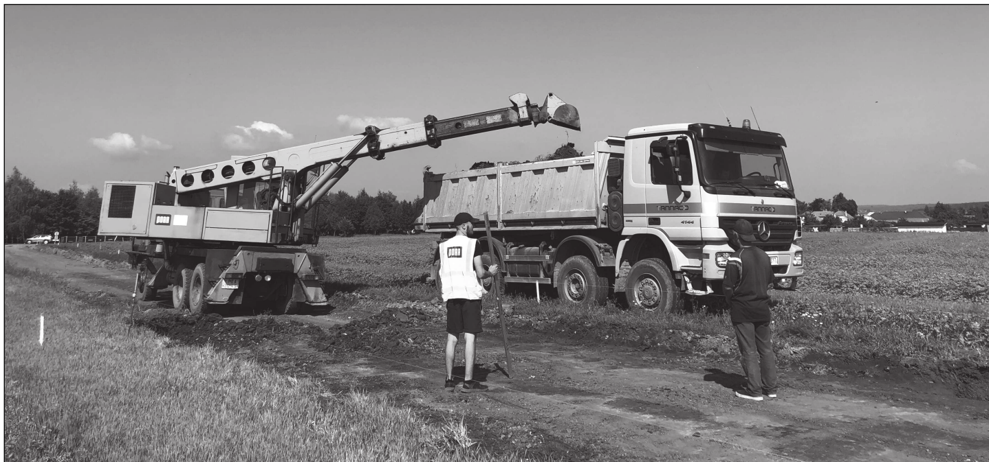
Těžká technika na horní části cesty strhává starý zhutněný povrch.
